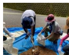
③土嚢へ土入れ
